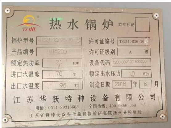
现有锅炉型号
