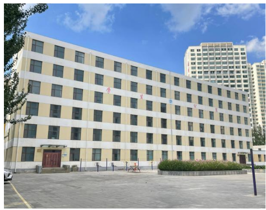
宿舍楼拆除（建教学楼）
