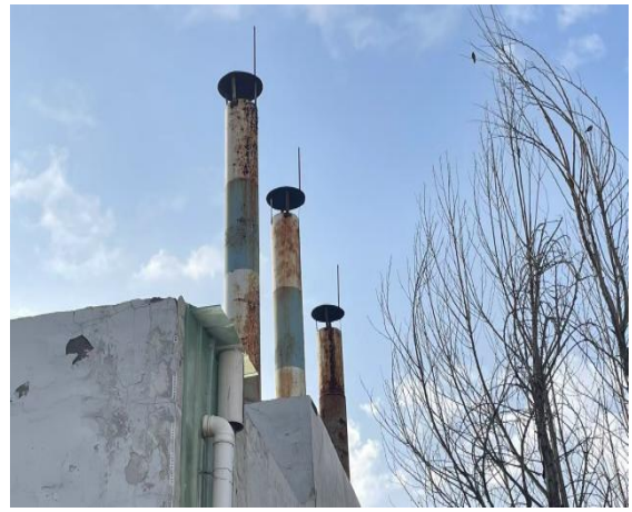
现有锅炉排气筒
