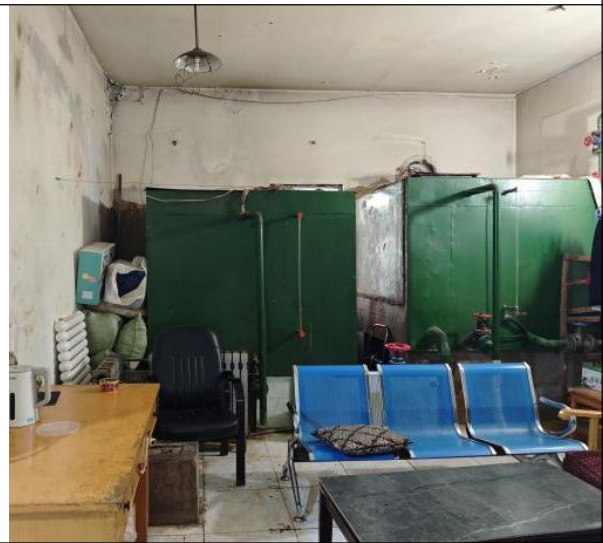
2楼水箱及工作人员休息区域
