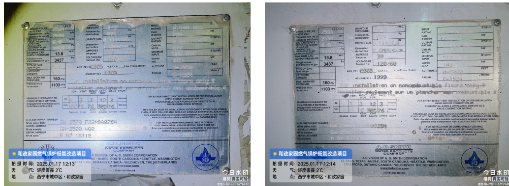
16 台 1t/h 燃气锅炉 图 2-5 原有锅炉照片
