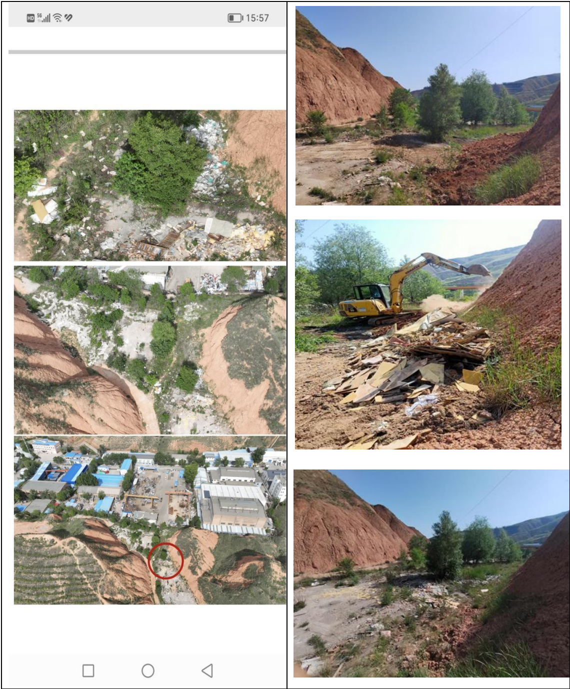
227 国道征迁遗留（原水磨村 182 洪沟）整改完成。
