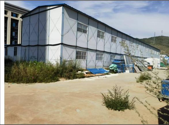
项目建设地（南川中学项目部）
