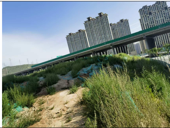
项目区北侧南绕城高速
