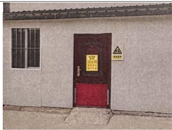
现有医院医疗废物暂存间现状
