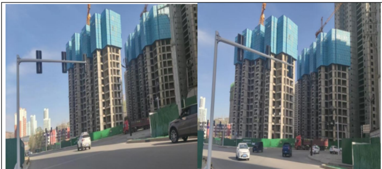
项目区东南侧待建公路局家属院
